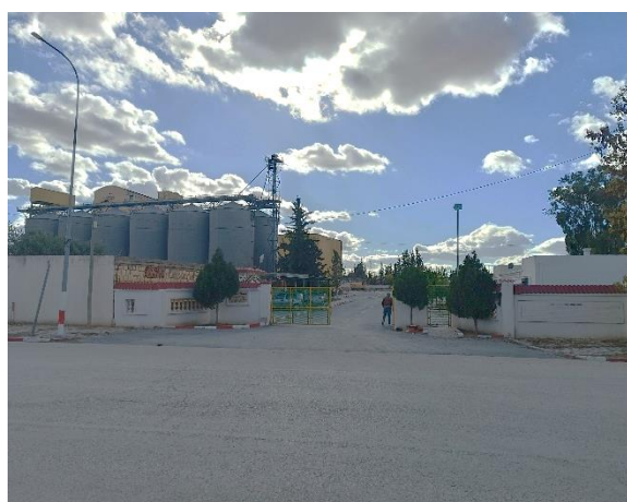
Figure 17 : Façade principale du site
