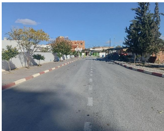
Figure 1 : Entrée du silo de Dahmani
