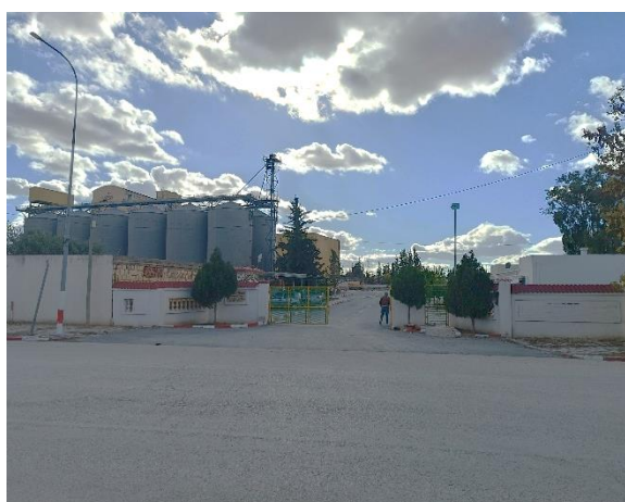
Figure 17 : Façade principale du site
