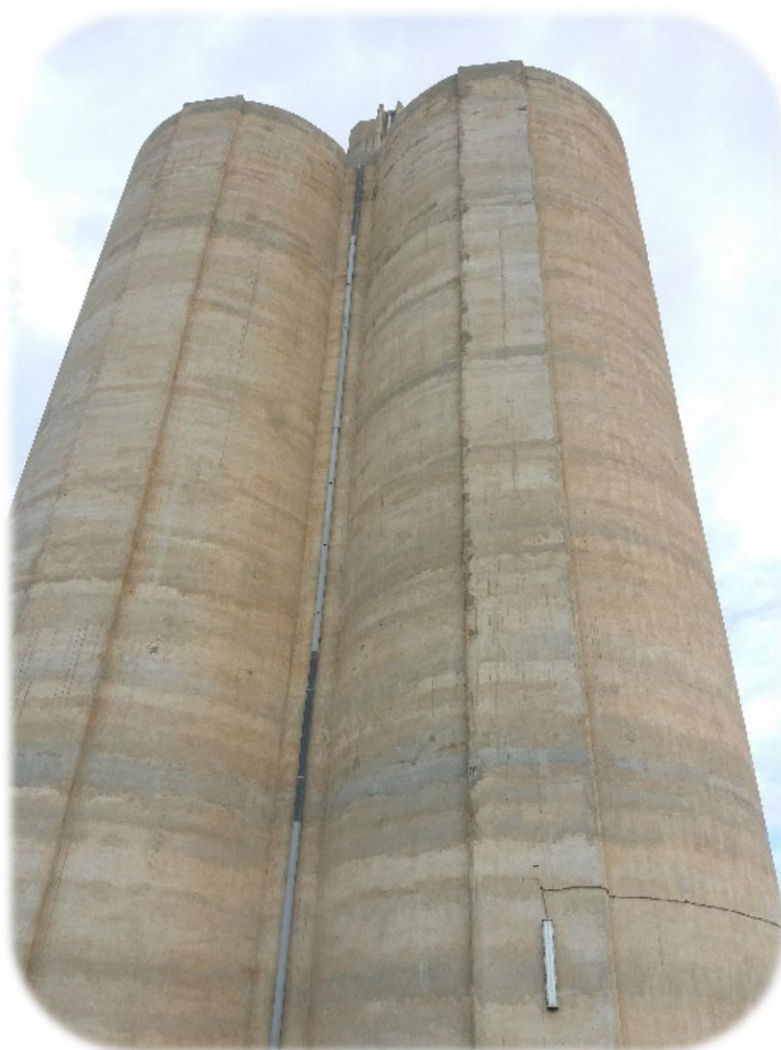
Photo 9 : Façade des cellules
