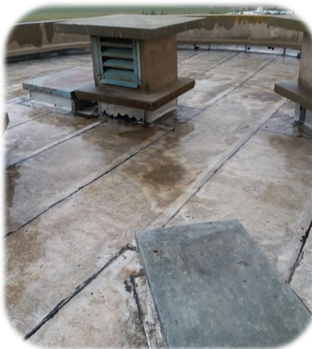
Photo 5 : Etanchéité en SP44
