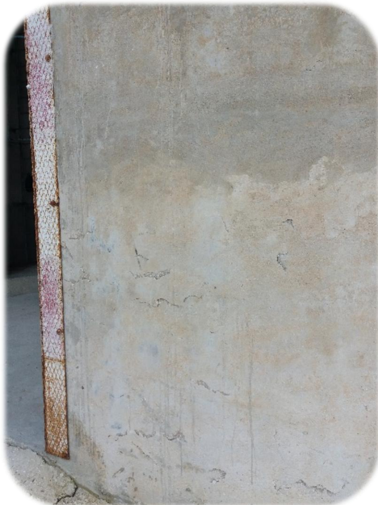
Photo 14 : Dégradation superficielle
