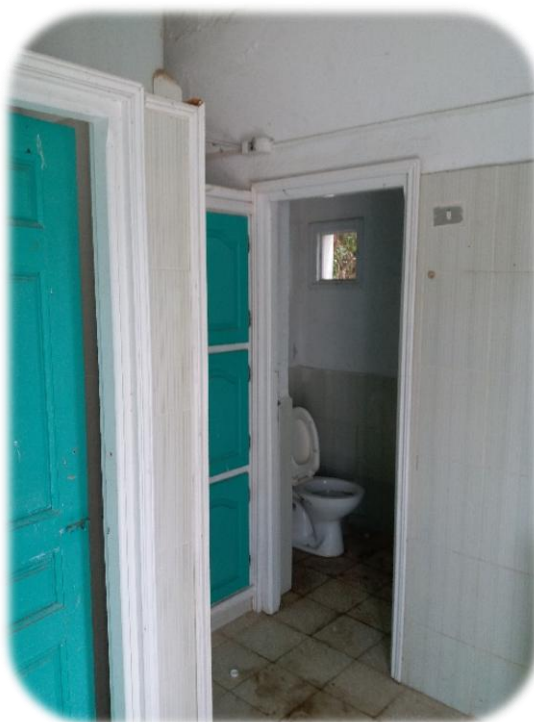
Photo 7 : Bloc sanitaire de l'administration
