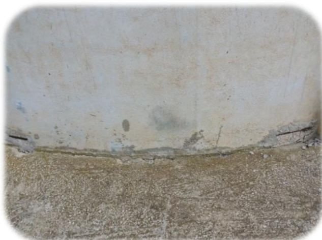
Photo 20 : Décollement du revers d'eau, corrosion d'armature et éclatement du béton
