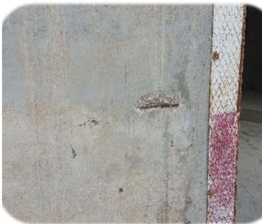
Photo 13 : Ferrailage nu et corrodé
