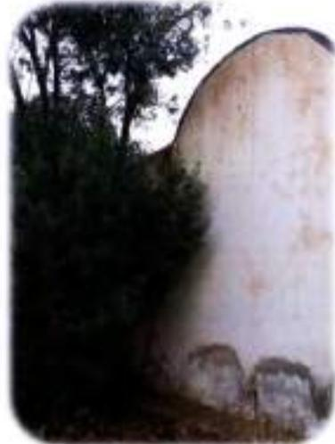
*Photo 22 : Humidité dans les murs extérieurs*
