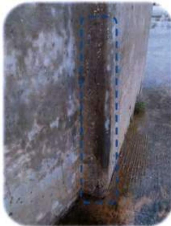
*Photo 17 : éclatement du béton suite à la corrosion d'armature*
