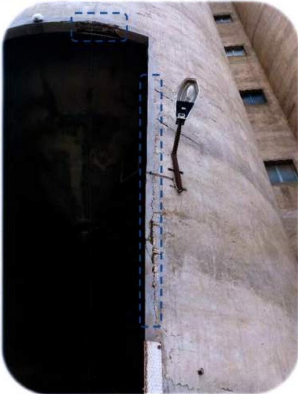
**Photo 16** : éclatement du béton et corrosion d'armature
