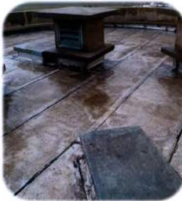
*Photo 5 : Etanchéité en SP44*
