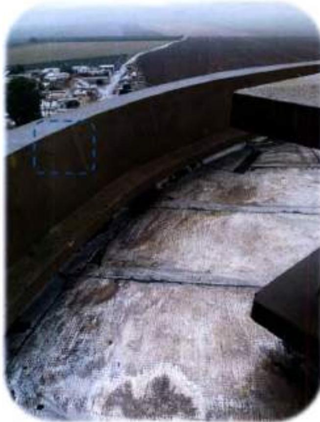
**Photo 19** : Fissure suite à la corrosion d'armatures au niveau de l'acrotère
