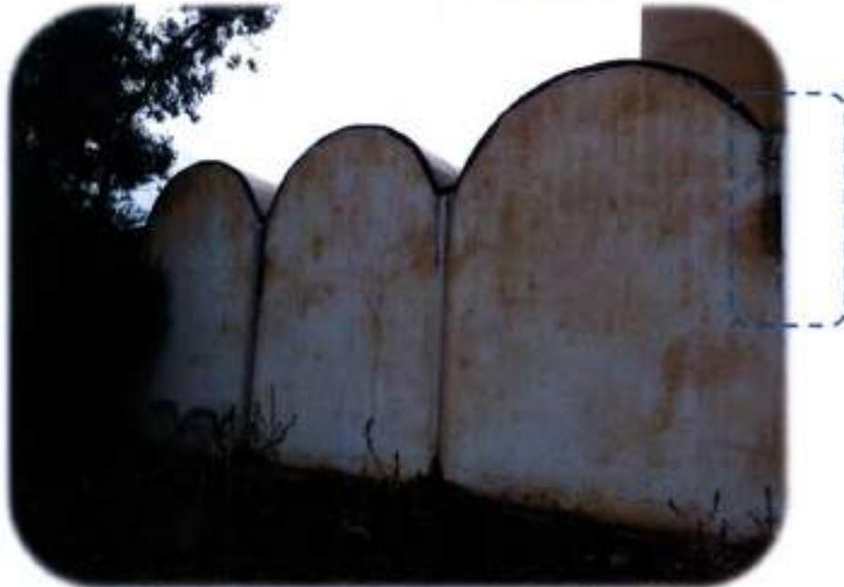
*Photo 21 : Traces d'infiltration des eaux pluviales dans les voutes*
