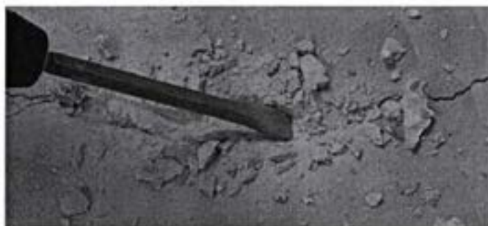
Figure n° 11 : calfeutrement avec un mortier ou un mastic d'une fissure déformée en rectangle
