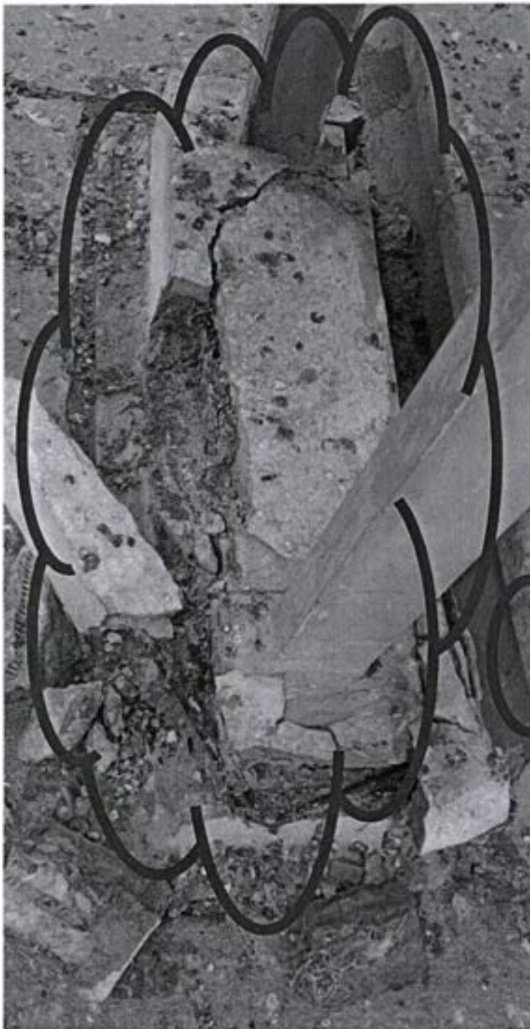
Localisation de l'anomalie au niveau d'un plot Type 1
